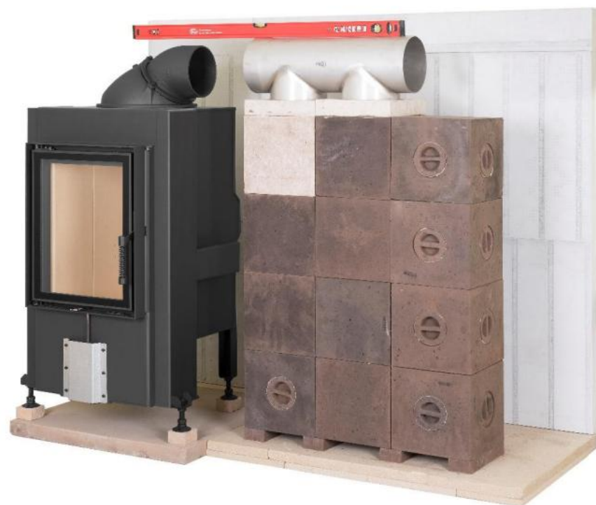
29) A szelep felhelyezése és a síkság mérése lazán rögzített kupolával.
